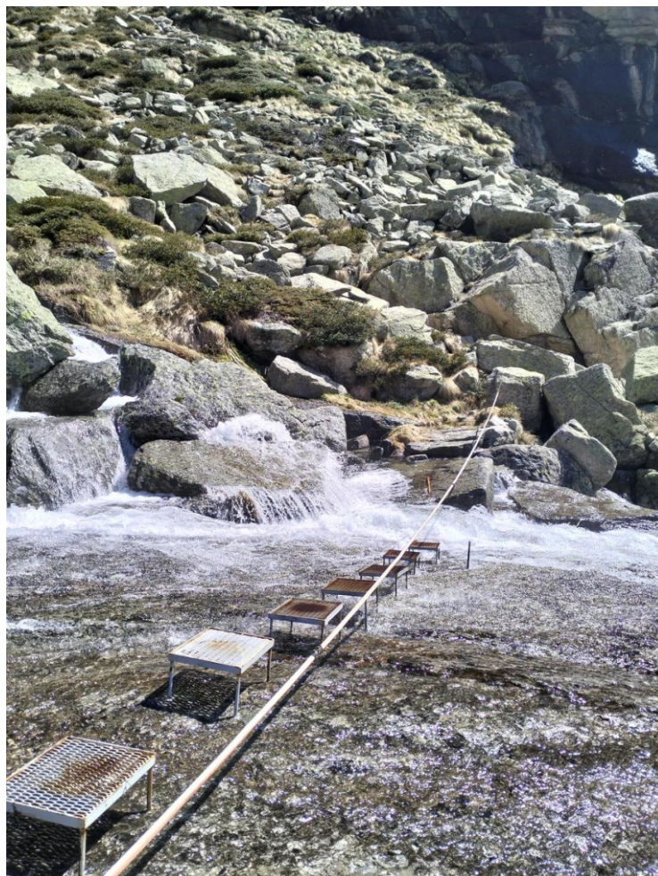
Guado sul torrente Vassola
